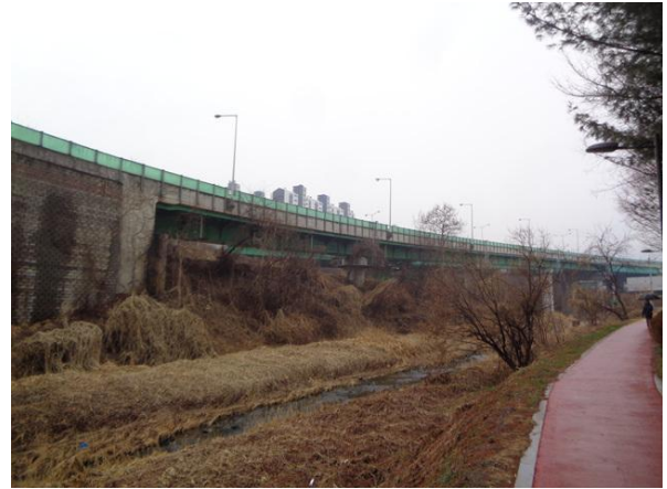
교량 측면 전경
