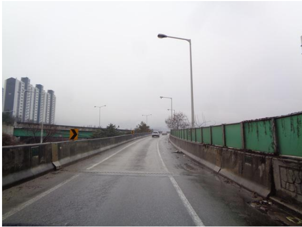
교량 상부 전경
